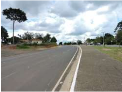
Rua Paraná (Rodovia Waldomiro Correia de Camargo – SP-079) com imóvel a esquerda
